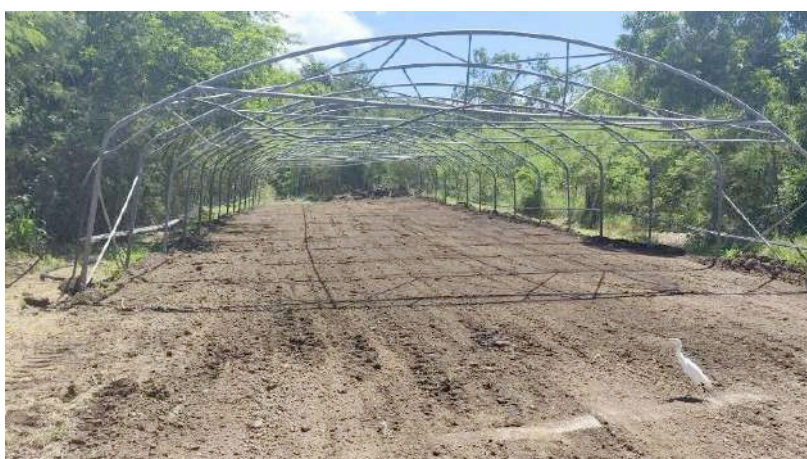
Aménagement de la deuxième pépinière (Assofwi 2025)
