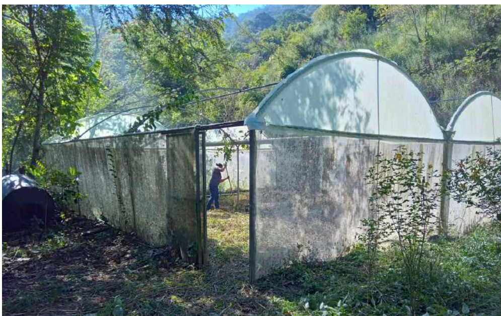
Pépinière communautaire en construction
